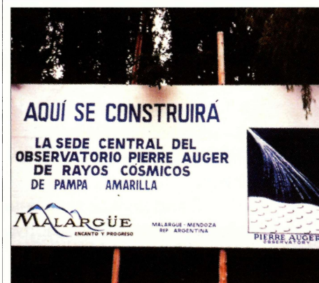
L'Observatoire Pierre Auger "en chantier" dans la province de Mendoza, en Argentine. (James Cronin, projet Pierre Auger.)
