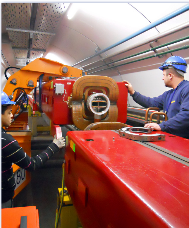
Les équipes changent un aimant du SPS au cours d'un arrêt technique. (Image de Franck Bais).
