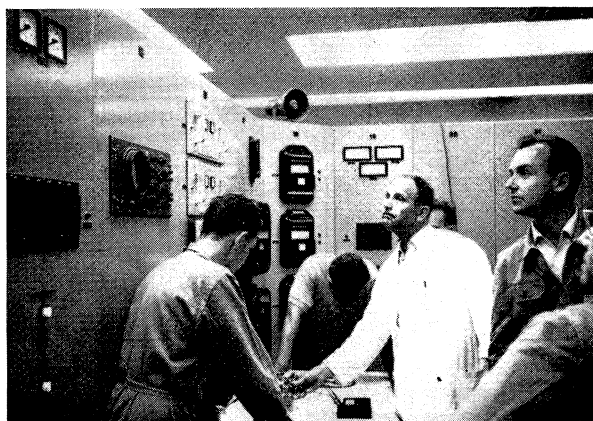
Un dernier potentiomètre est tourné. H. von Ballmoos et M. Georgijevic observent intensément les deux appareils de mesure dont les indications diront si la mise sous tension est effective.
