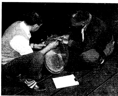
J. Augsburg et R. Stierlin qui se sont partagé le développement des prototypes de la «plate-forme pneumatique» soulèvent le joint en caoutchouc ceinturant un des disques expérimentaux. Ce joint est à présent étudié par les bureaux de dessin PS et SC en vue de sa production industrielle. (Photo CERN)
