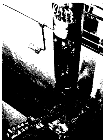
Dispositif de blocage du cœur du réacteur PEC prototype. PEC (Prova Elementi Combustibile = Essais Eléments Combustibles) est un réacteur à neutrons rapides, 118 MWth de puissance, en construction près du Centre ENEA de Brasimone (Bologna, I.)
