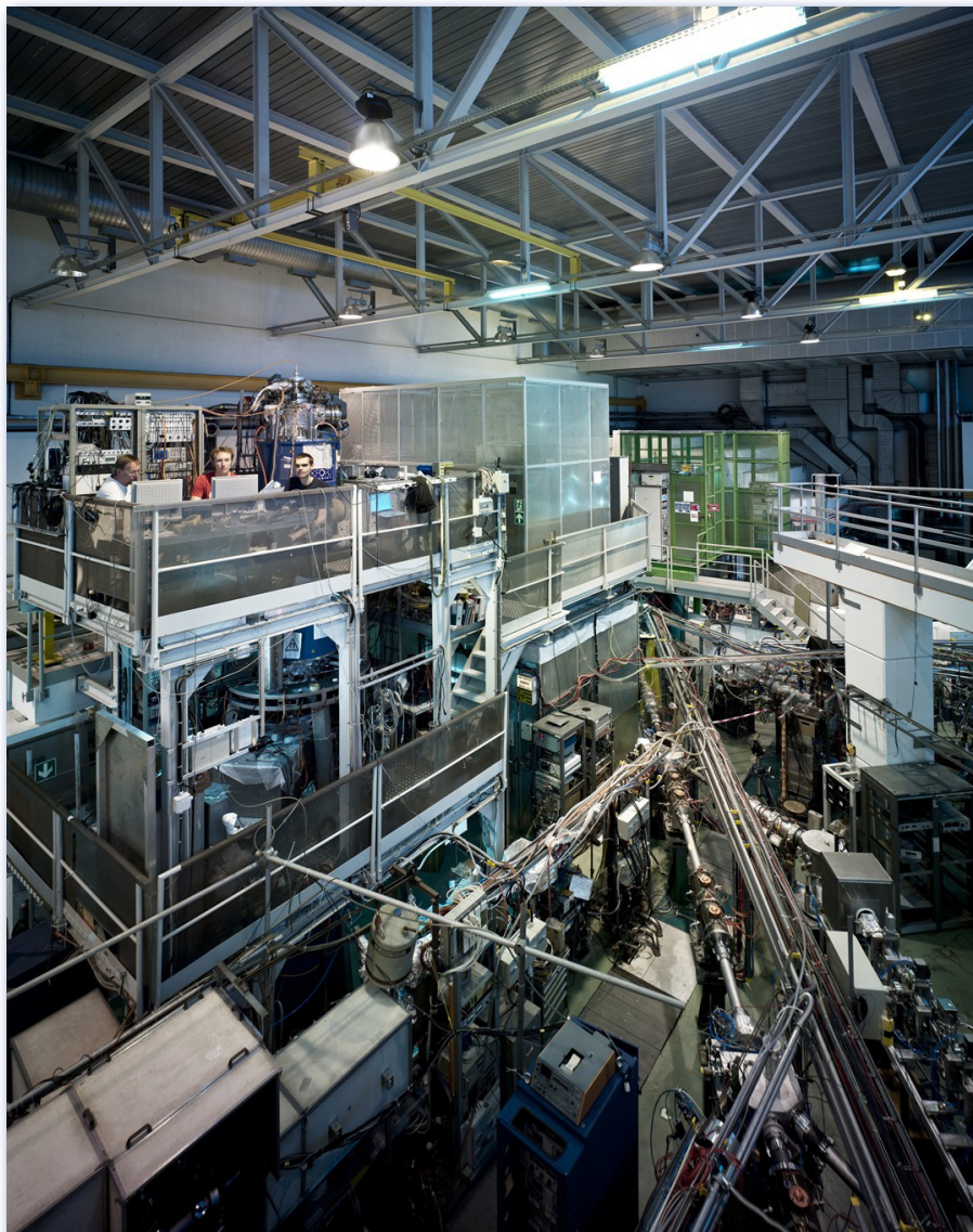
Vue d'ensemble de la zone d'expérimentation d'ISOLDE
