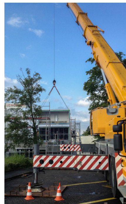
Opération délicate : la mise en place de 11 constructions modulaires au-dessus de la cantine du Jardin d'enfants. Image: Sigrid Knoops.
