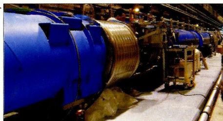
Chaîne d'essai des aimants supraconducteurs du collisionneur LHC du CERN. Le LHC est l'un des grands pôles des travaux de recherche et développement en supraconduction appliquée.
