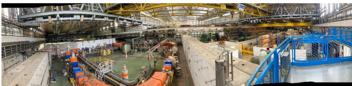
Figure 56 : vue panoramique de l'ensemble du bâtiment 150. Auteur : Jules Grandvillemin
