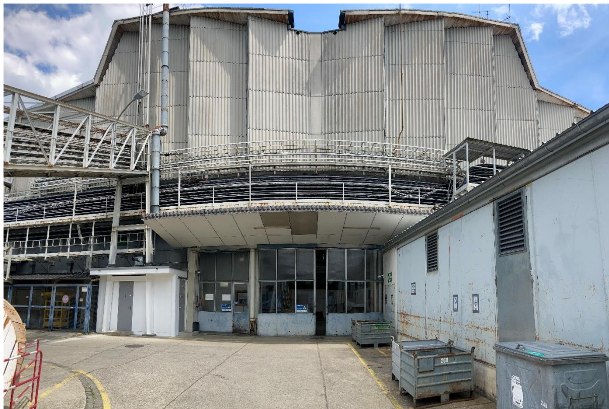
Figure 53 : vue de l'entrée principale du bâtiment 150. Auteur : Jules Grandvillemin
