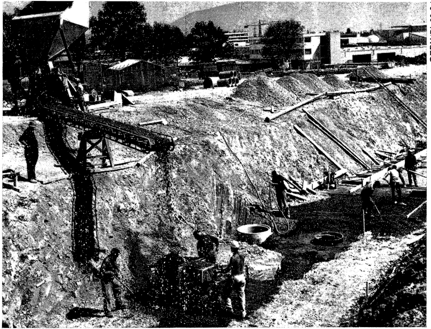
Construction d'un tunnel de service, au début de juin, à l'extrémité nord-est du terrain des anneaux de stockage. On aperçoit à l'arrière-plan une partie des bâtiments actuels du CERN.
