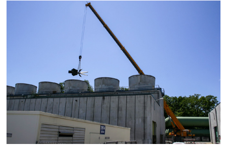
Installation d'un ventilateur de tour de refroidissement au Point 6 du LHC, en 2009. Une opération similaire sera réalisée d'ici quelques semaines.
