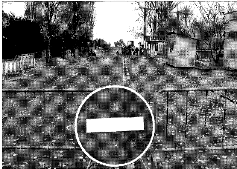
Travaux à l'entrée A.
