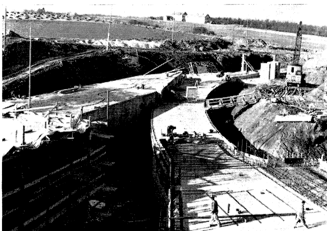
La photo ci-dessus, prise pendant la construction du SP, montre le tunnel annulaire et l'axe de l'accélérateur linéaire (à gauche), avant que la structure en béton ne soit recouverte de terres. A droite, l'alignement des trois sections de l'accélérateur linéaire de 50 MeV. La sortie des particules se trouve à l'avant-plan.
