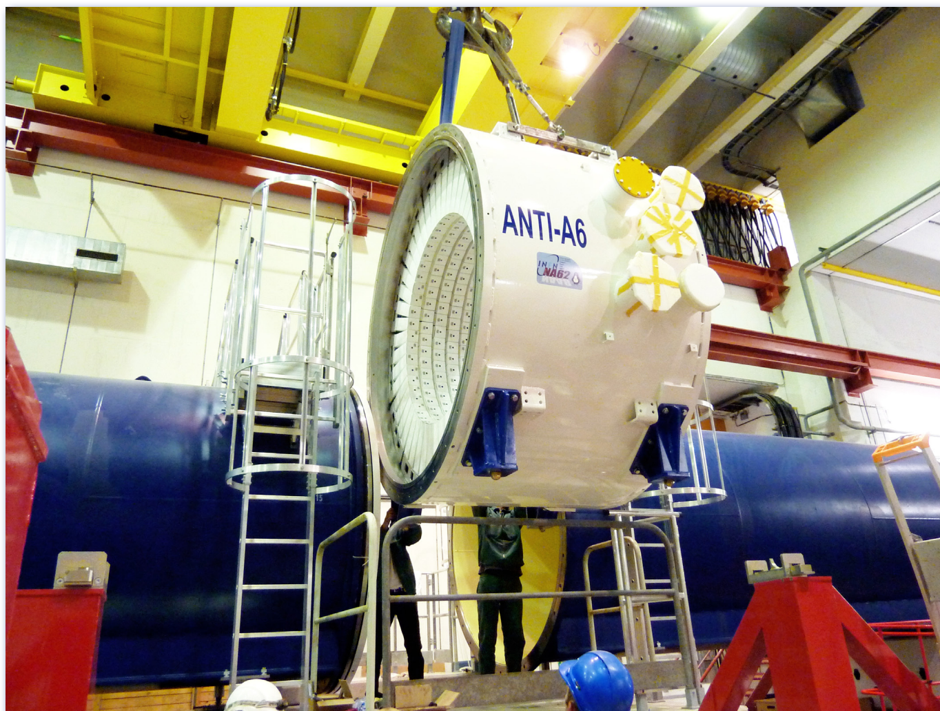
Une des stations LAV est insérée dans l'enceinte à vide de NA62.
