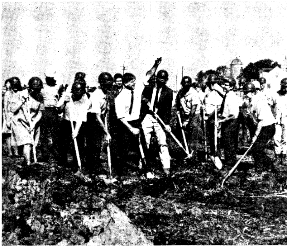
Cérémonie du premier coup de pioche de l'anneau principal à Batavia. Les machines pourront prendre la relève, à condition de travailler un peu plus vite... La date fixée pour la mise en place des éléments de l'accélérateur principal a été avancée de six mois. Le directeur du Laboratoire, R. R. Wilson, se reconnaît facilement: il est le seul sans casque !
