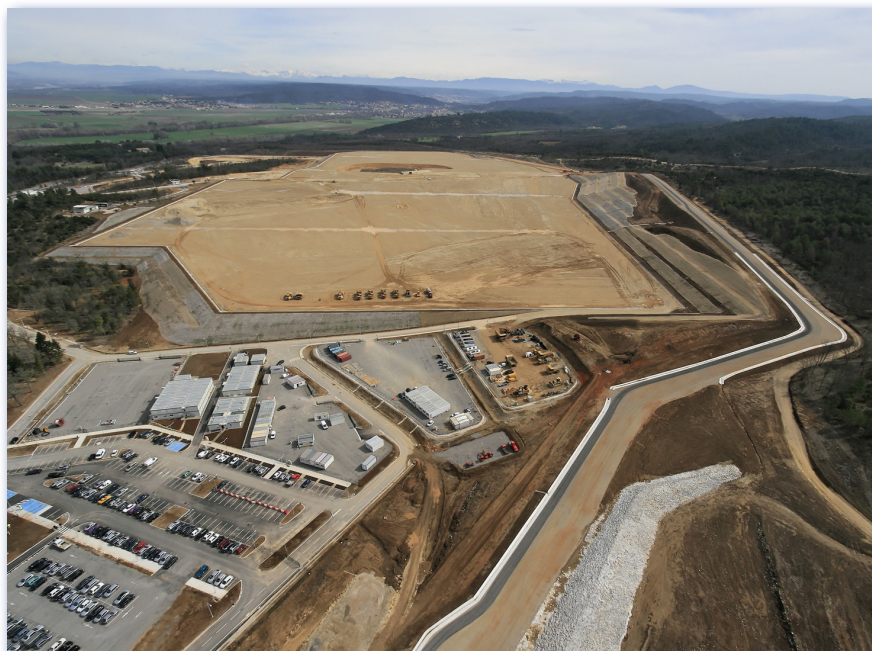
Une vue aérienne du site de construction d'ITER, à Cadarache, en France, orientée vers le nord. Au fond, à l'extrémité de la plate-forme, on peut distinguer le Tokamak. (© Agence ITER France)
