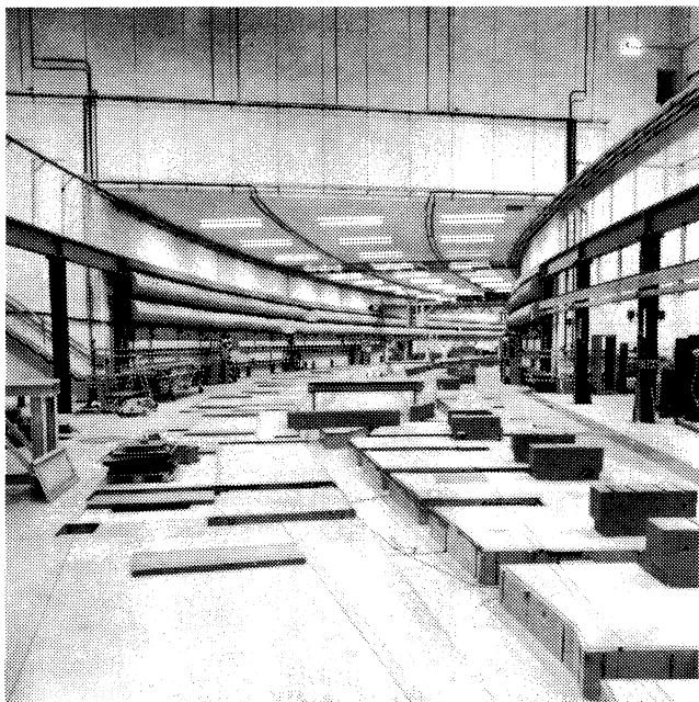
L'octant 4 des ISR photographié en août depuis l'intersection 4. L'ensemble des aimants et les équipements annexes ont déjà disparu. C'est dans cette zone que seront faites, à partir de la fin de l'année, les mesures des premiers aimants de déflexion de LEP. (Photo 289.8.84)
