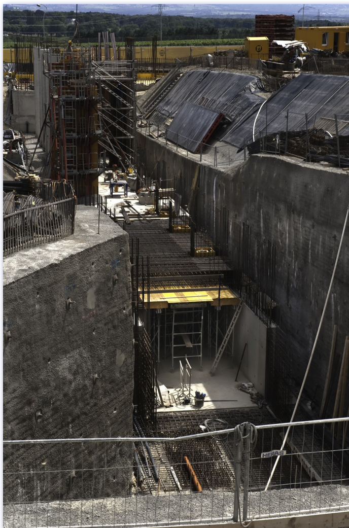
Les travaux de génie civil du nouveau Linac 4 près du restaurant n°2.
