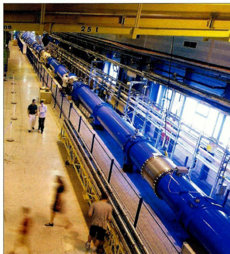
L'installation String 2: une cellule complète du LHC dans la partie régulière d'un arc du collisionneur.
