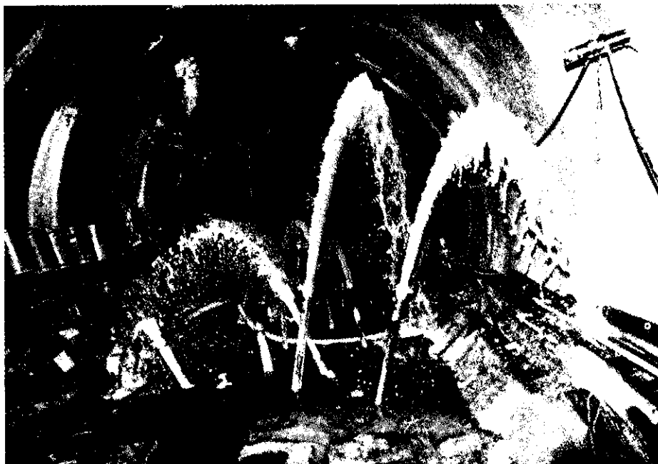
Après avoir pénétré 3 km à l'intérieur du Jura, le tunnel du LEP a été temporairement arrêté par une venue d'eau provenant de derrière le front de taille.
