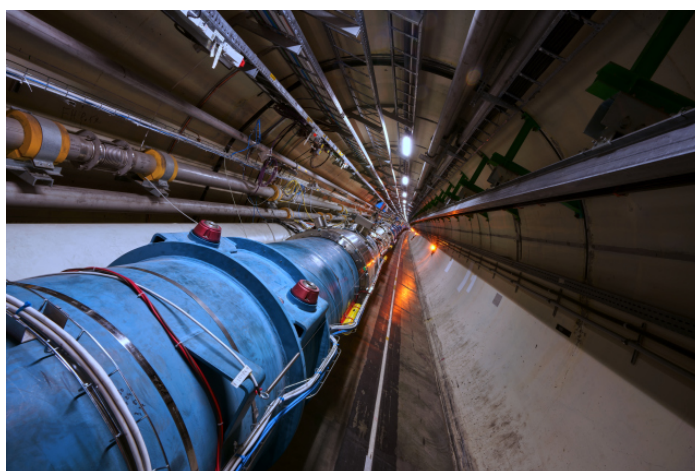
FIGURE 1 – Tunnel du LHC (© Brice Maximilien, CERN)
