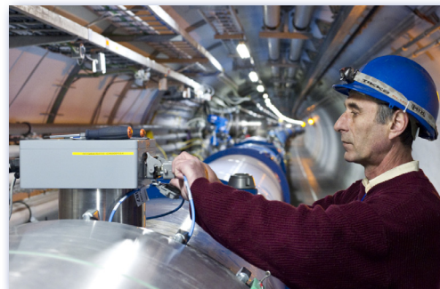
Dans le tunnel les équipes travaillent à améliorer la fiabilité électrique du système de protection des aimants.
