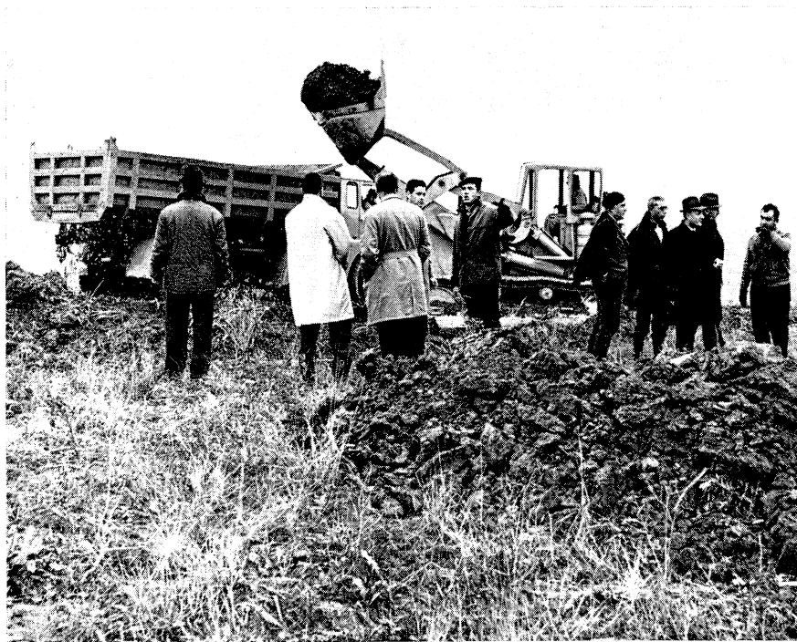
Feu vert pour le tunnel des ISR. Cette photographie a été prise le 2 novembre lorsque les travaux ont commencé sur l'emplacement des anneaux à intersections, dans la partie du CERN sise en France. Les terres enlevées en creusant ce tunnel circulaire, qui a un diamètre moyen de 300 m, une largeur de 15 m et une hauteur de 7 m environ, seront transportées en un lieu de décharge situé de l'autre côté de la route Genève - Saint-Genis, grâce à un tunnel percé sous la route. Toutefois, les terres qui serviront par la suite à former le bouclier entourant les anneaux de stockage, seront disposées sur place.
