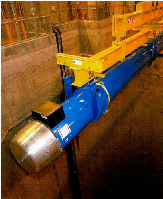
La descente du premier dipôle du LHC par son puits ovale.
