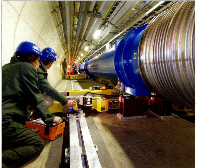
Finalement, l'aimant dipolaire supraconducteur est en position dans le tunnel du LHC.
