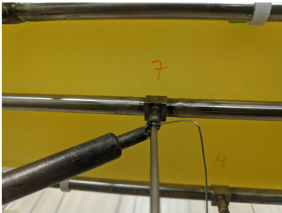
Figura 58. Soldadura blanda de los tubos de conexión.
