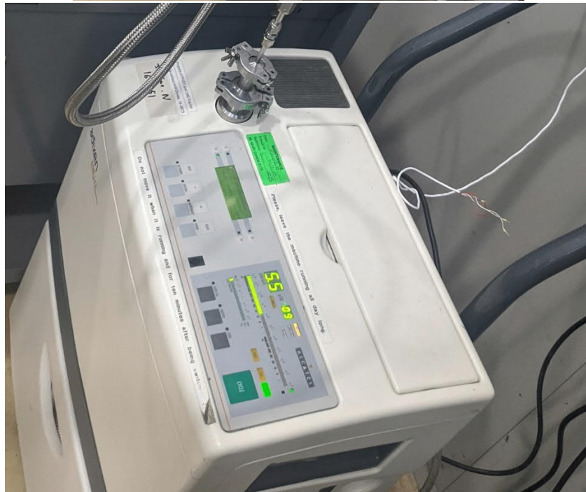
Figura 81. Resultado de la prueba de fugas de helio del colector de salida.
